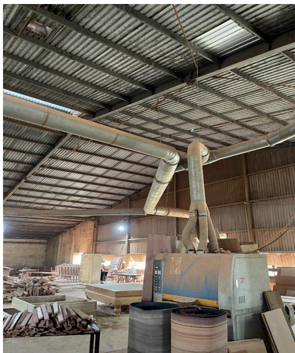
Hình 10. Hình ảnh hệ thống thu gom, xử lý bụi tại Nhà máy
