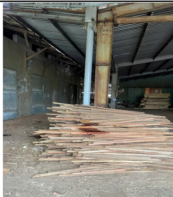
Ổng thoát nước mưa từ mái
