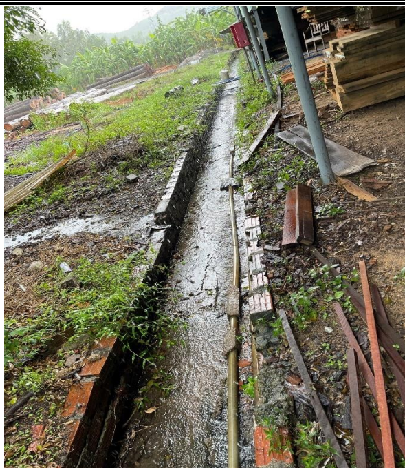
Mương thoát nước mưa nhà máy
