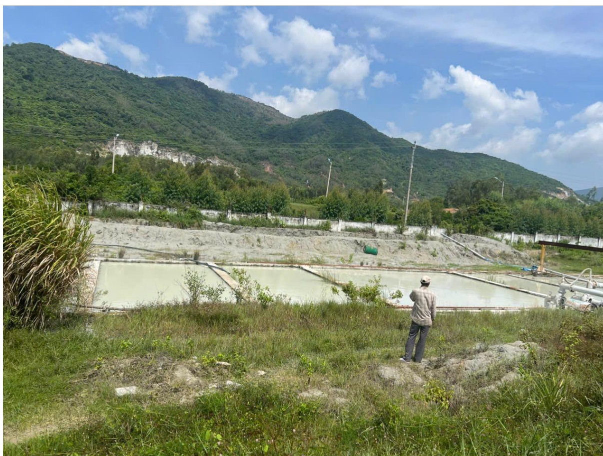
Hình 3. 5. Hiện trạng các hồ lắng tại khu vực dự án
